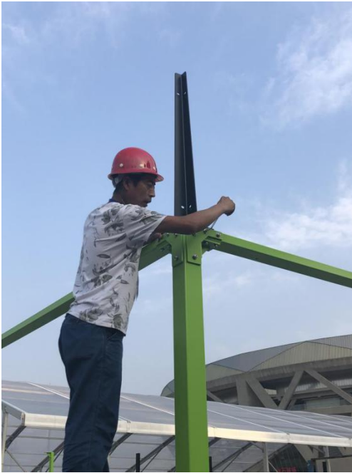
Skiss för installation av tvärstångens anslutningsplatta Fig. 9
