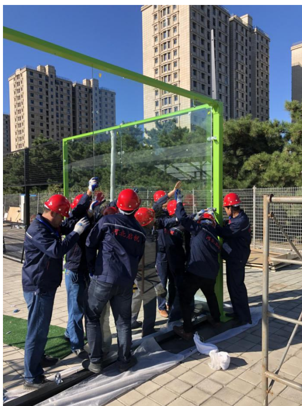
Öronplatta och anslutningsplåtinstallation Fig. 10
